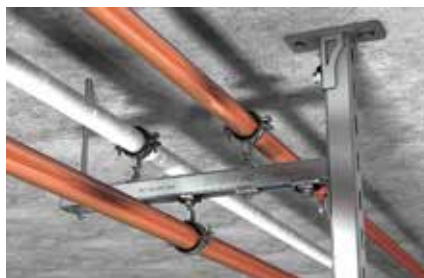
Staffaggio con mensola a soffitto e profili FLS
