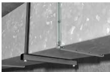
Condotte di ventilazione con profili
