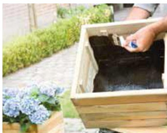
Figura 2 Lavori di impermeabilizzazione in giardino
