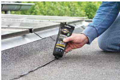
Figura 1 Sigillare crepe giunti e fessure
