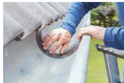
Figura 3 Riparare perdite nelle grondaie
